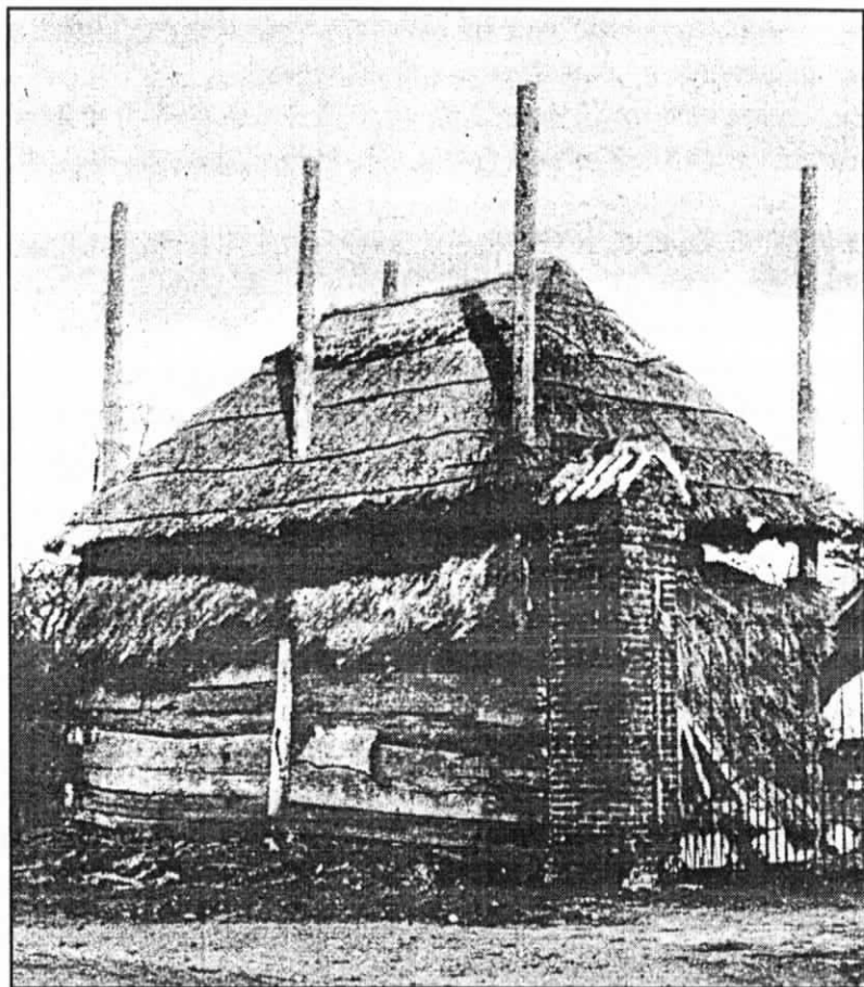
Niet alleen de woning maar ook de hooioppers of "paalschuur" werden van een strooien "kap" voorzien.
