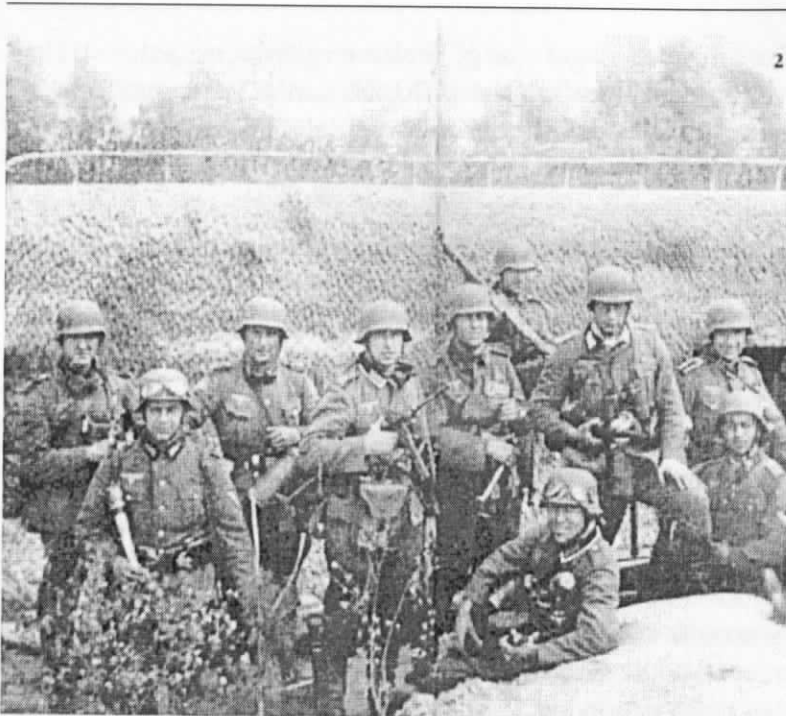
M.G. bat.6 te Arendonk op 12 mei aan een bunker aan de linkeroever na hun oversteek over het kanaal.
