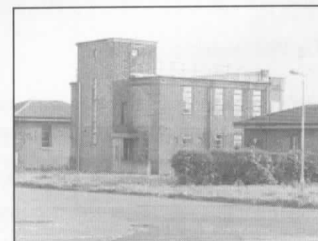
Controletoren in zijn huidige staat
