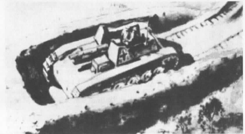
Een 18/1 Wasp zelfstandige Houwitser (10,5 cm) in een dug-in. Het wagengedeelte is verborgen en beschermd. In ene eenvoudige achteruit rijbeweging kan het voertuig de aftocht blazen.
